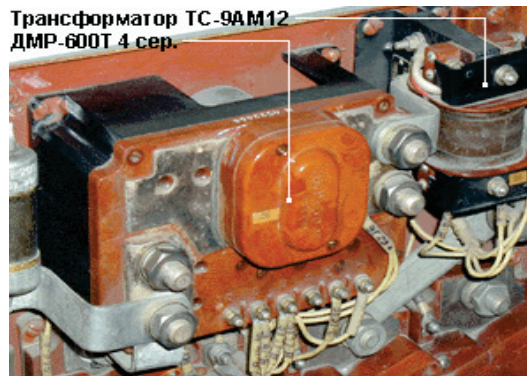
Рисунок 1.17. Установка ДМР-600Т и ТС-9АМ12 в РК генераторов
