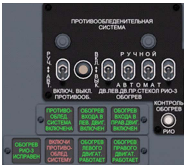
Рисунок 1.99. Панель управления противообледенительной системой
