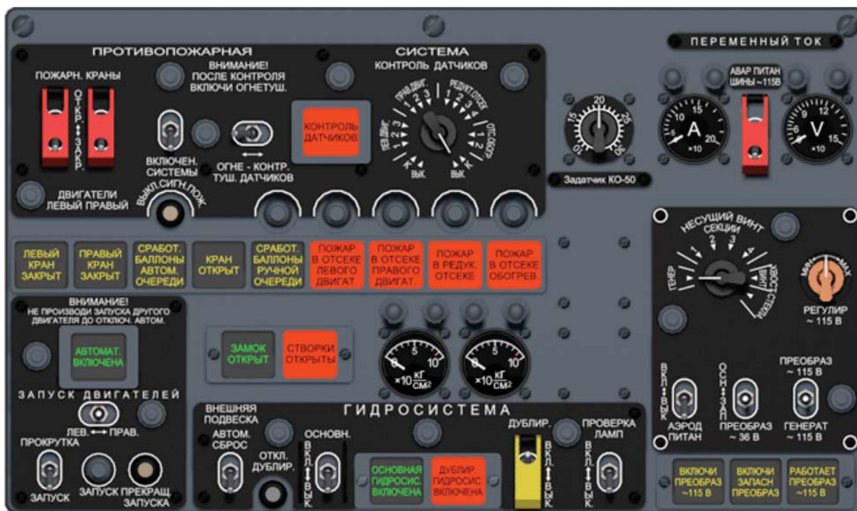
Рисунок 1.34. Средняя панель электропульты пилотов, справа – пульт переменного тока.
