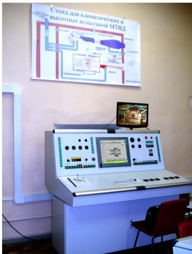
Рисунок 6 – Пульт управления стендом для испытаний ТВД
